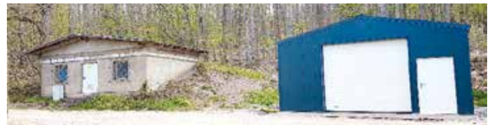
(Im Bild: links der alte Hochbehälter, rechts das neue Technikgebäude)
