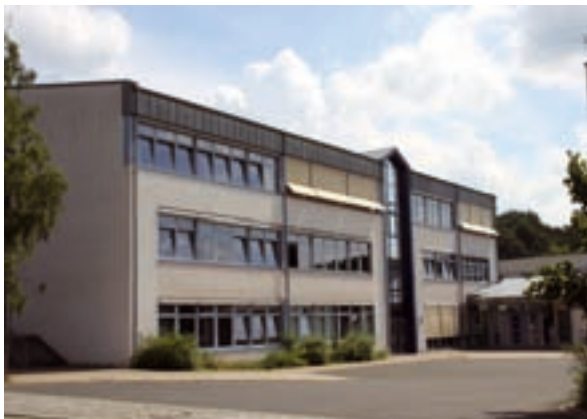
Grund- und Mittelschule Schlüsselfeld
