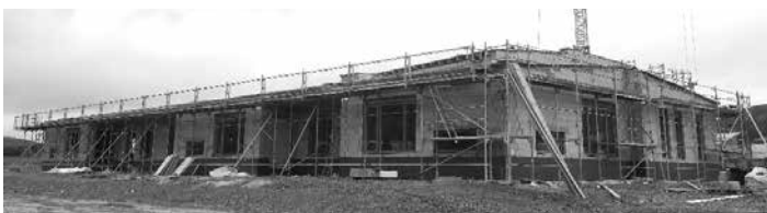
Bild: Baufortschritt Kinderkrippe
