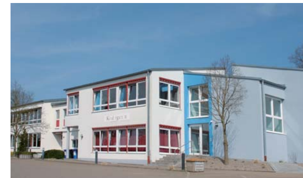
Kindergarten und -krippe in Geiselwind
