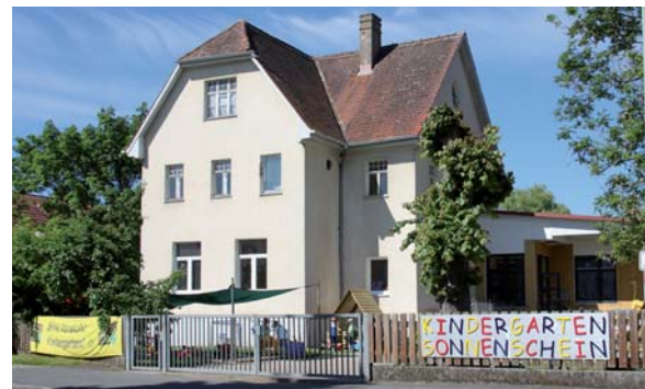
Städtischer Kindergarten im Schlüßelfelder Ortsteil Elsendorf
